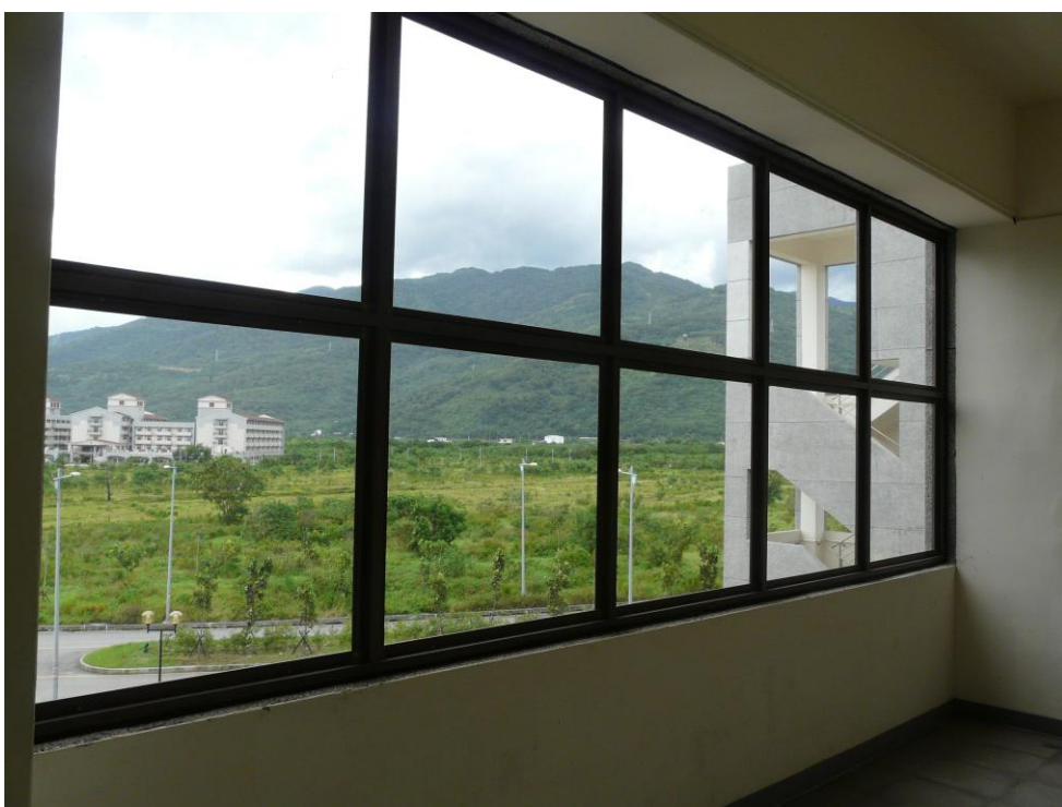
人文學院走廊四樓 不銹鋼沙網
