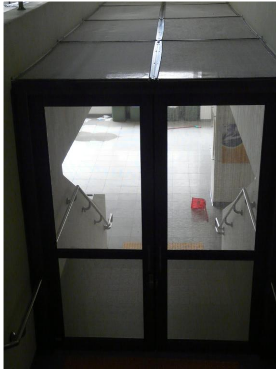
人文學院走廊四樓 雙開鋁門
