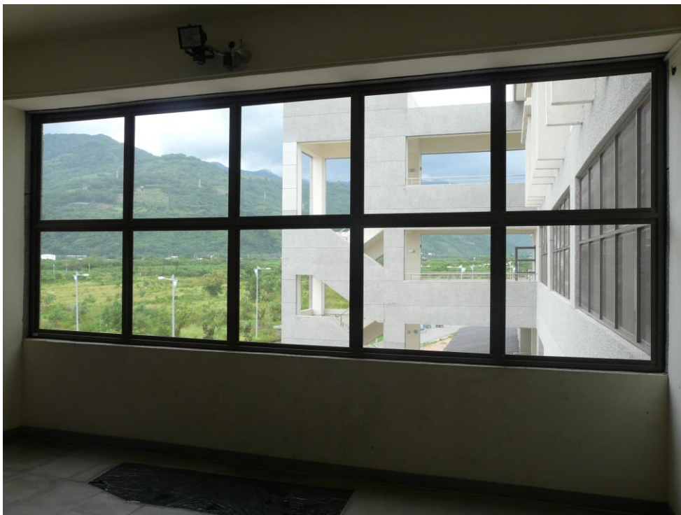
人文學院走廊四樓 不銹鋼沙網
